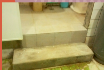
▲ 施工後 (增設階梯，降低高度落差)
