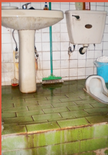
▲ 施工前 (門口高度落差極高)
